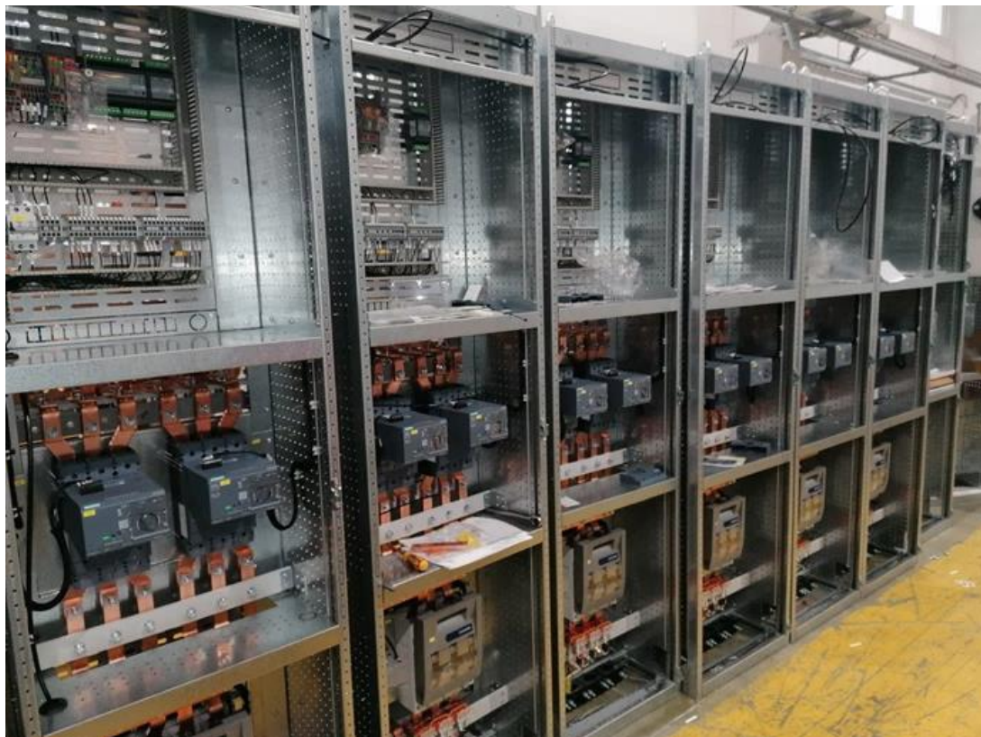
Rys. 4. Innowacyjna stacja SN/nn z dusystemową rozdzielnicą nn – widok wewnątrz
